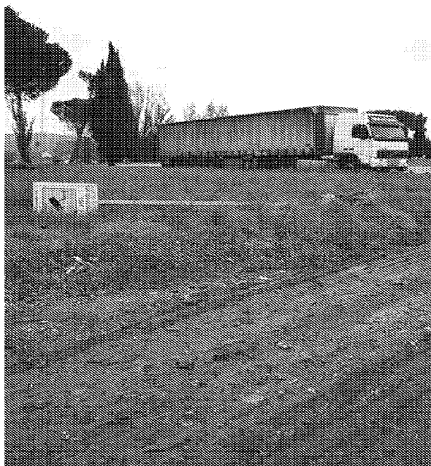
BIGLIETTO DA VISITA La condizione attuale del parcheggio dell'Autosole: è necessario un intervento urgente
