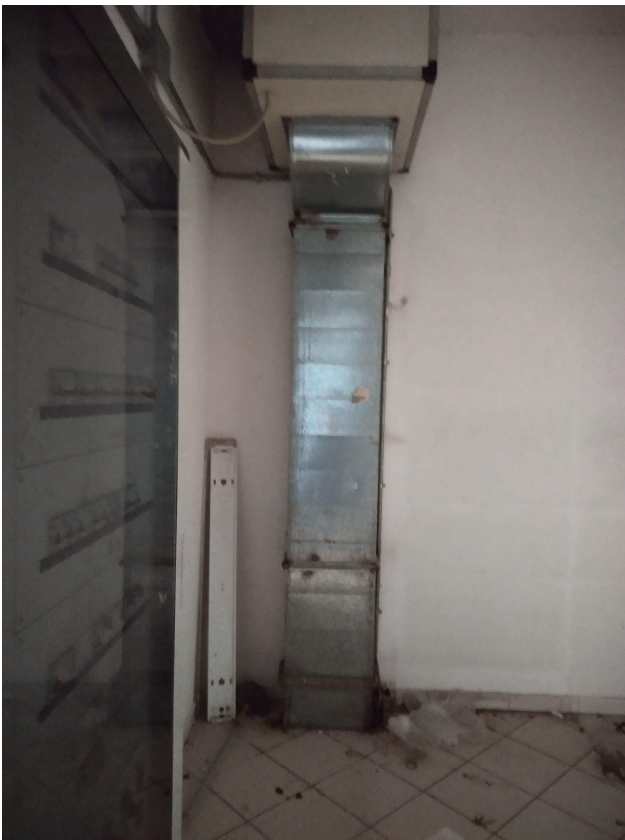
7 VISTA INTERNA DEPOSITO
