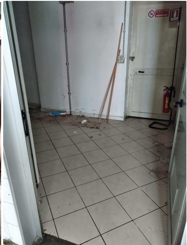
6 VISTA ZONA DEPOSITO
