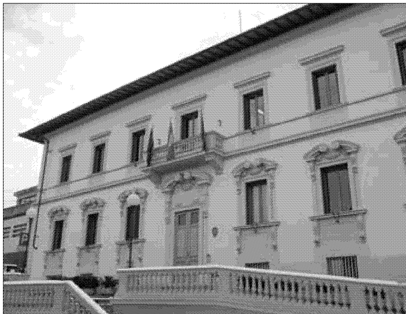
Sopra, il palazzo comunale di Bagno a Ripoli. In alto a sinistra il sindaco Luciano Bartolini
