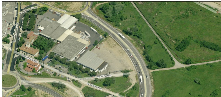
Fig. 10 – Foto aerea in dir. nord della nuova strada a 4 corsie denominata Nuova Via per Casellina, tra il “Fagiolone” e Via del Botteghino.
