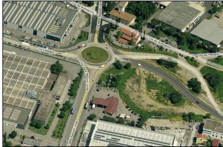
Fig. 12 – Foto aerea in dir. nord della nuova grande rotatoria tra Via Nazioni Unite e Via I maggio.
