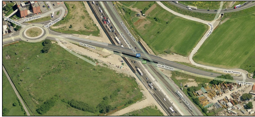
Fig. 9 – Foto aerea in dir. nord del nuovo cavalcavia sull’A1 tra Via del Pantano e della nuova rotatoria che porta al “Fagiolone”.
