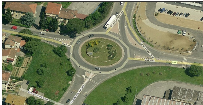
Fig. 13 – Foto aerea in dir. nord dell'incrocio Via Nazioni Unite, Via Pisana, Via Parlamento Europeo ristrutturato con una nuova grande rotatoria.
