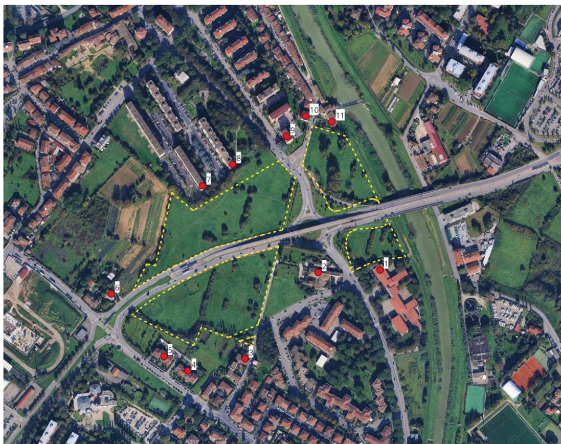
Figura 106. Ricettori prospicienti l'area di cantiere
