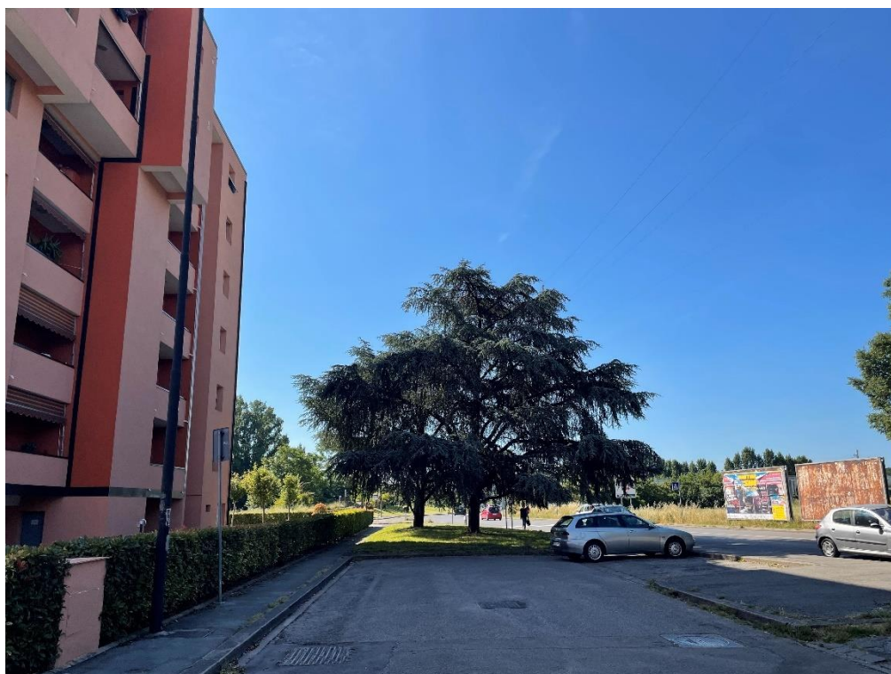
Figura 47. Edificio residenziale e annesso parcheggio la cui visuale affaccia sull'area di Piano
