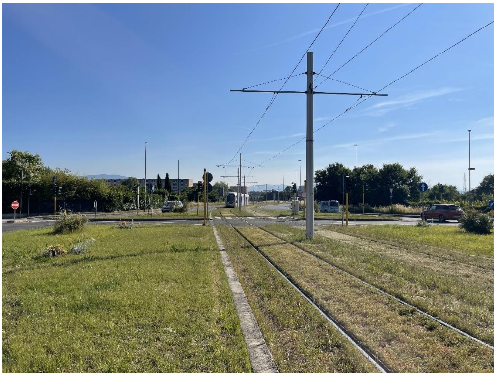
Figura 24. Linea Tram T1 proveniente da Firenze
