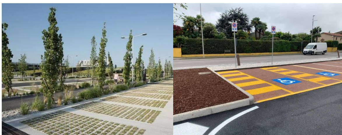
Figura 85. Pavimentazione drenanti parcheggi
