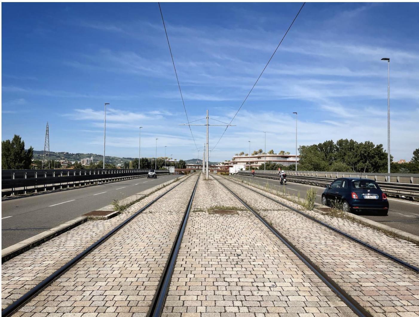
Figura 9 Foto 4 Post Operam
