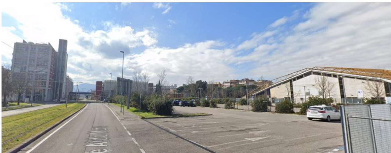
Figura 25. Viale Aldo Moro in direzione Palazzo Comunale. A destra Palazzetto dello Sport di Scandicci
