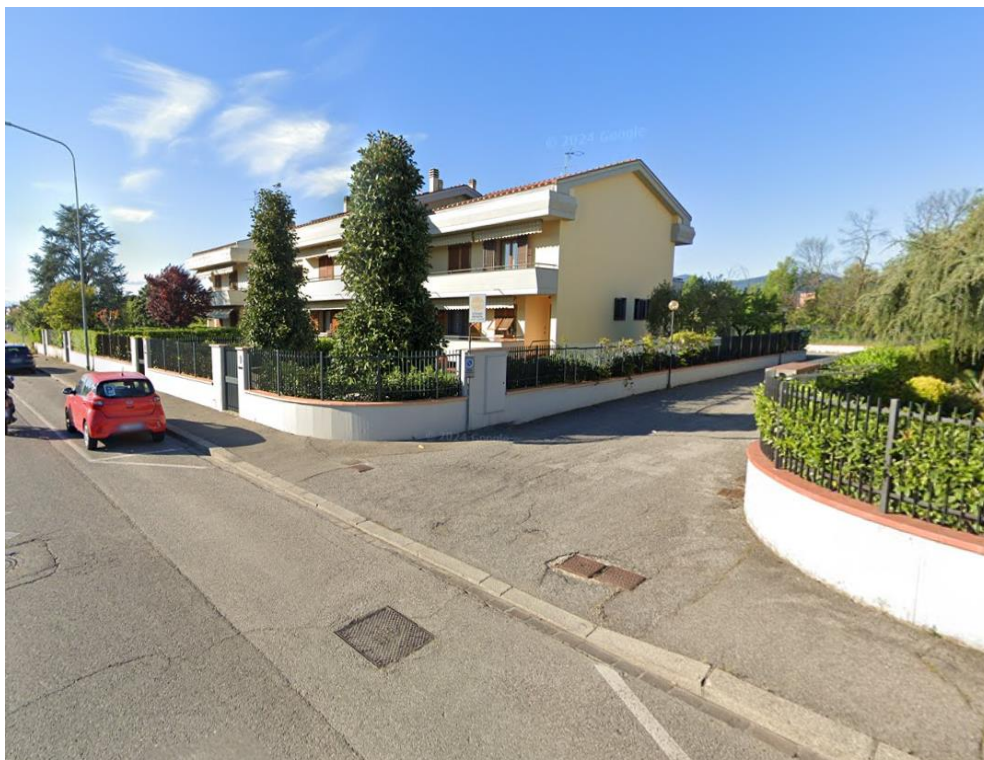
Figura 46. Edifici residenziali lungo Via della Marzoppina che occludono la vista sull'area di Piano
