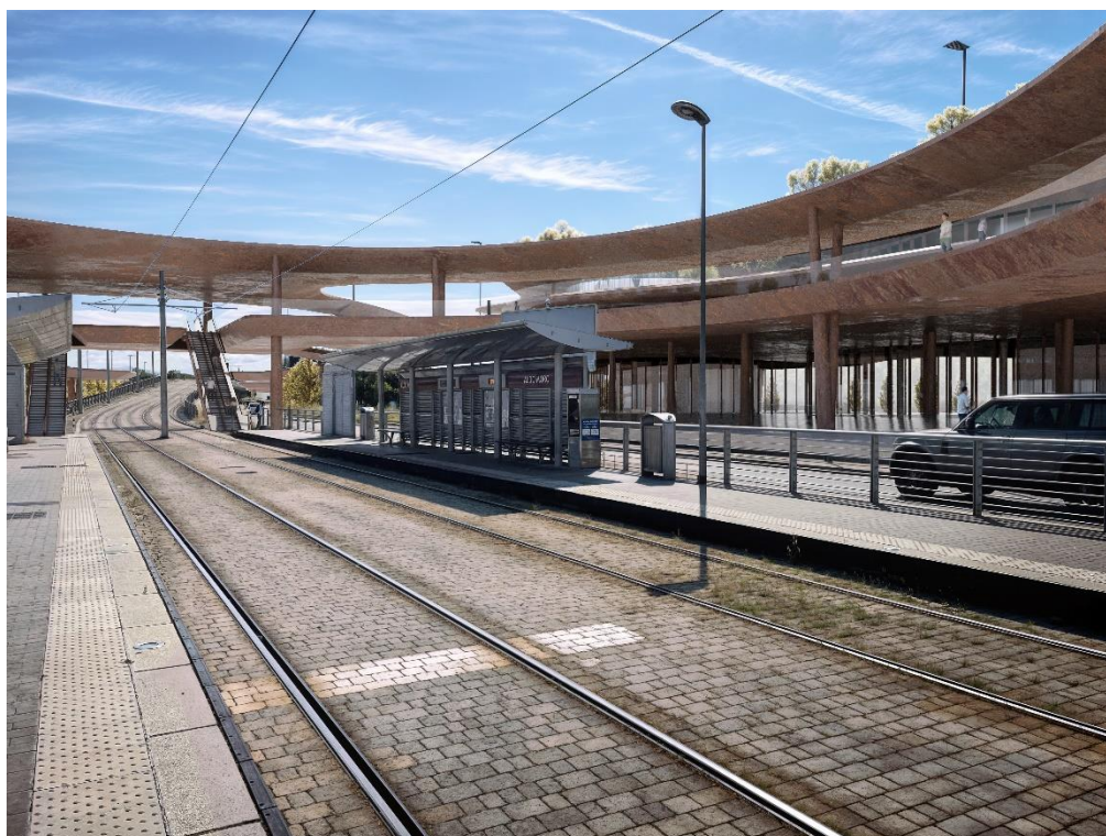
Figura 75. Foto 2 Post operam
