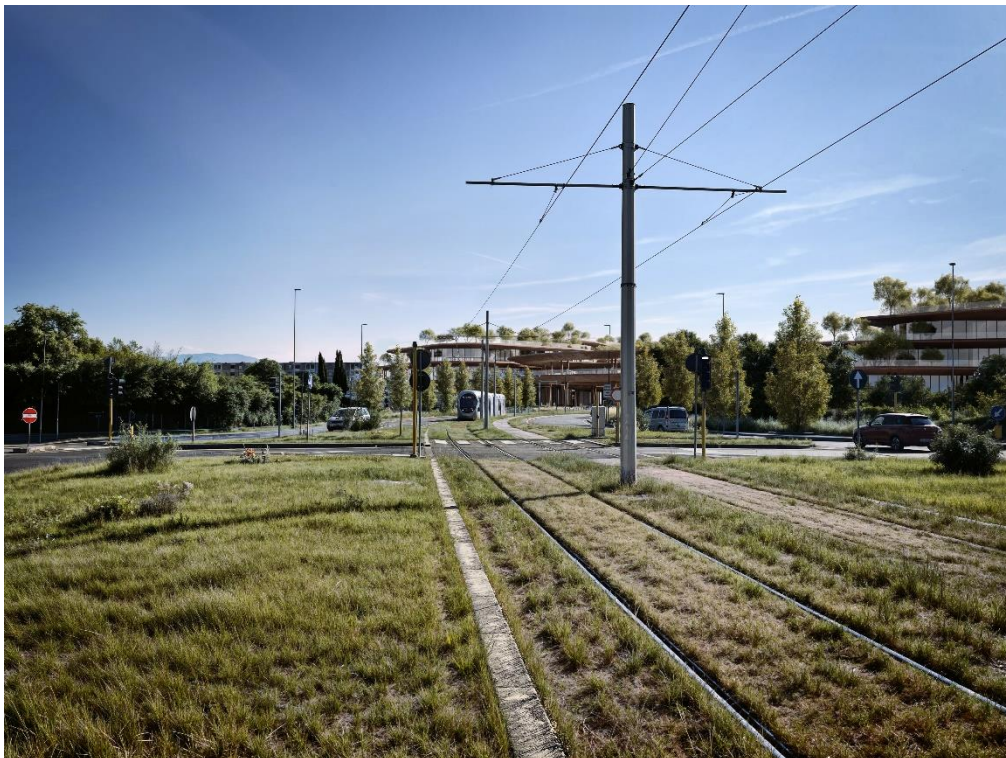
Figura 73. Foto 1 Post operam
