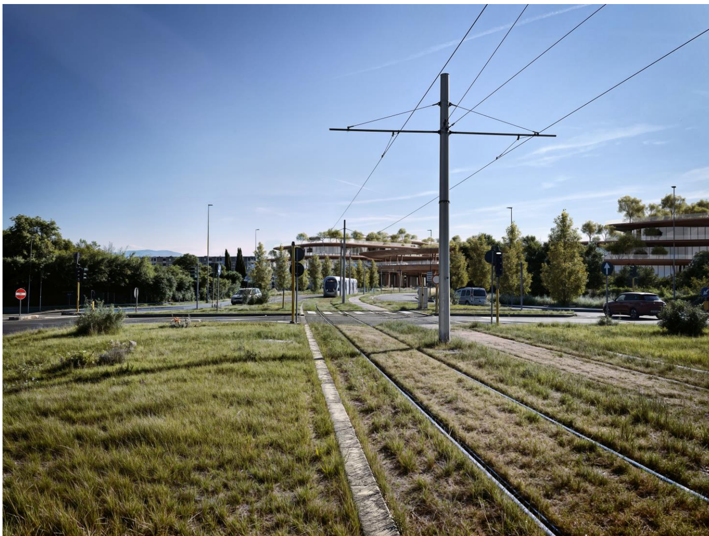
Figura 3 Foto 1 Post Operam
