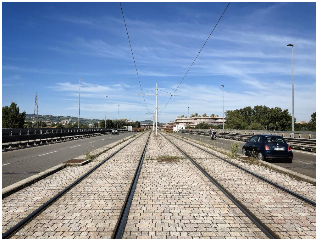
Figura 79. Foto 4 Post operam
