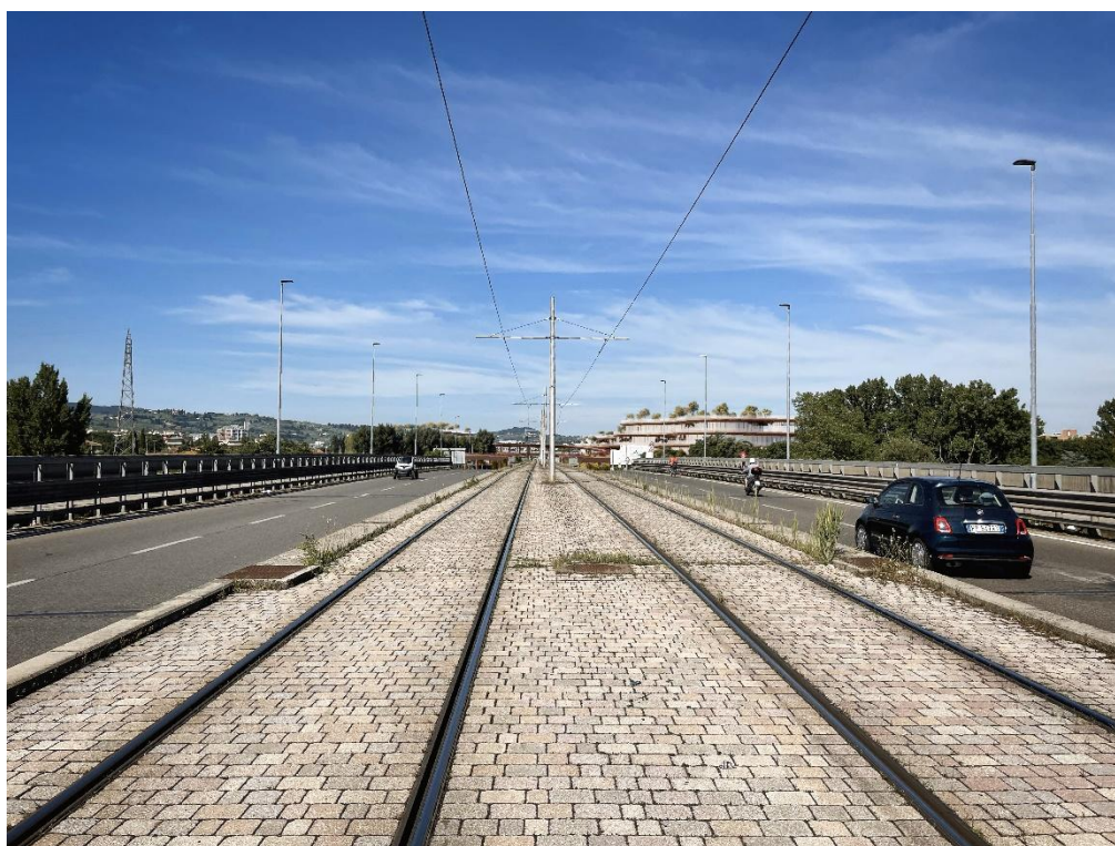
Figura 79. Foto 4 Post operam
