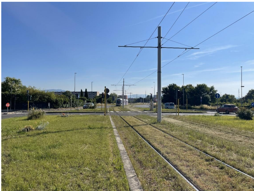
Figura 24. Linea Tram T1 proveniente da Firenze
