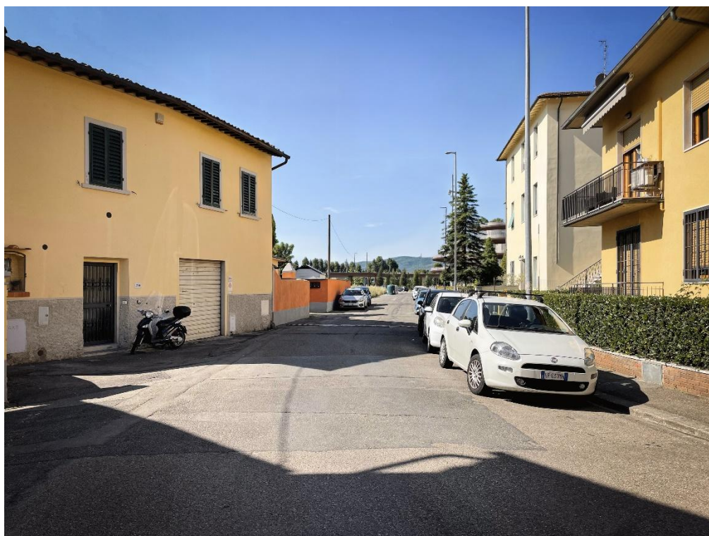
Figura 77. Foto 3 Post operam
