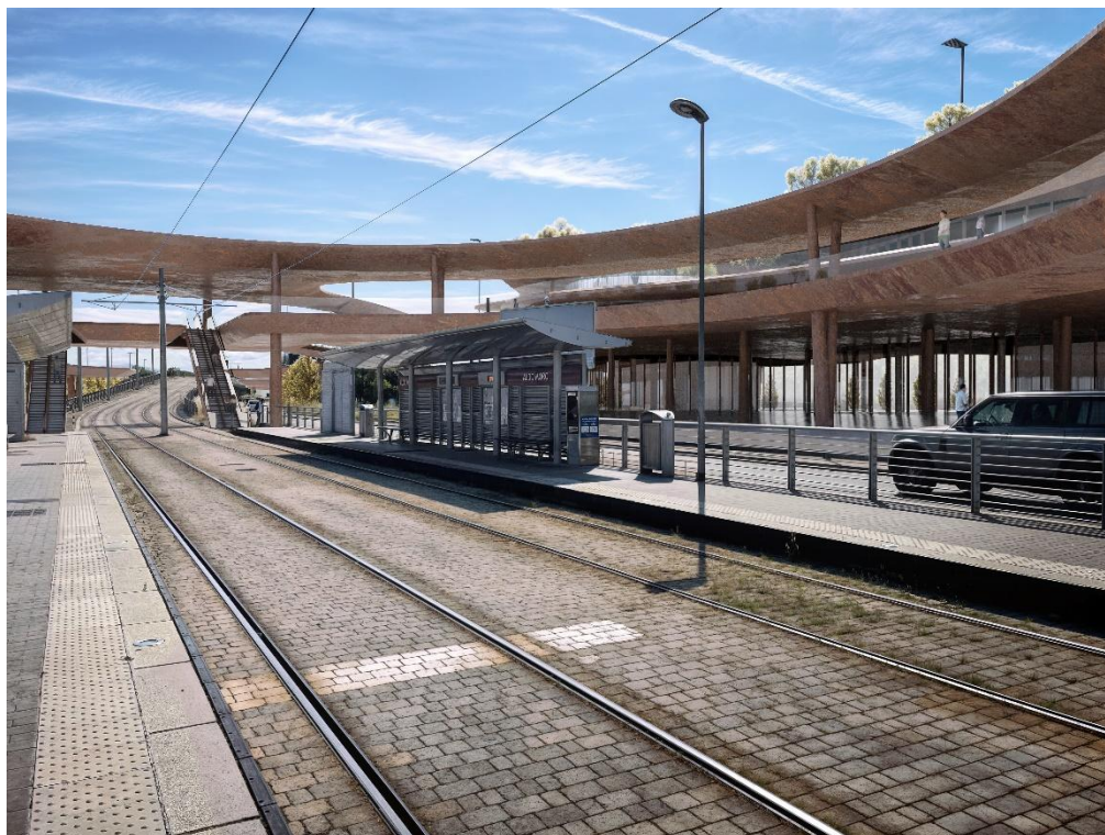
Figura 75. Foto 2 Post operam
