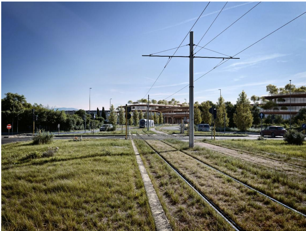
Figura 73. Foto 1 Post operam
