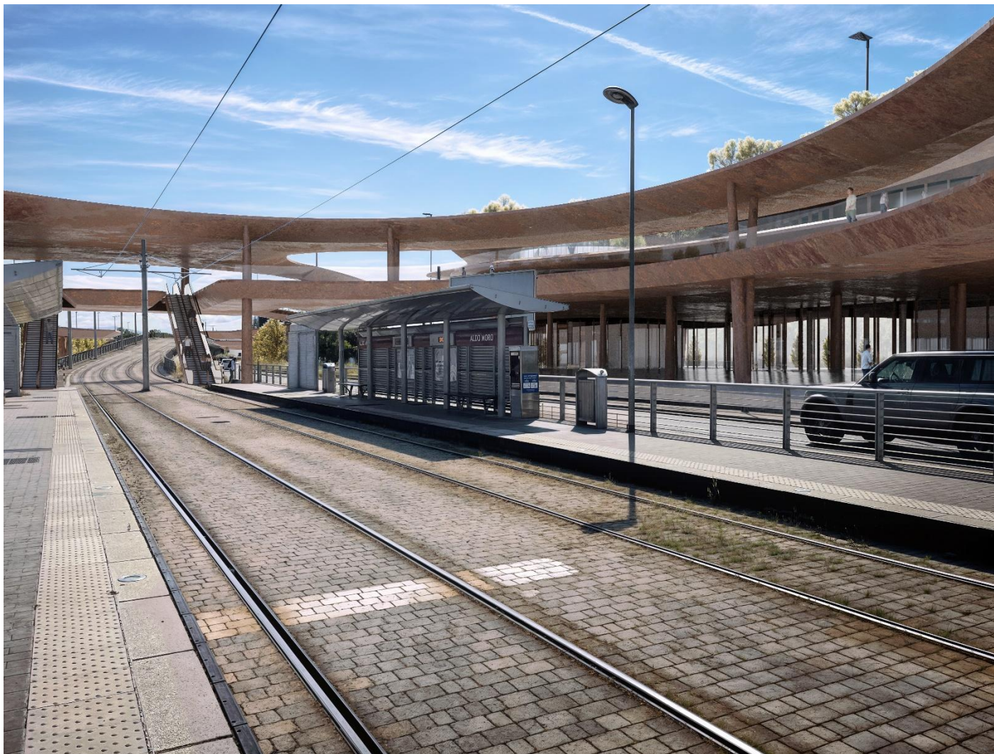
Figura 5 Foto 2 Post Operam
