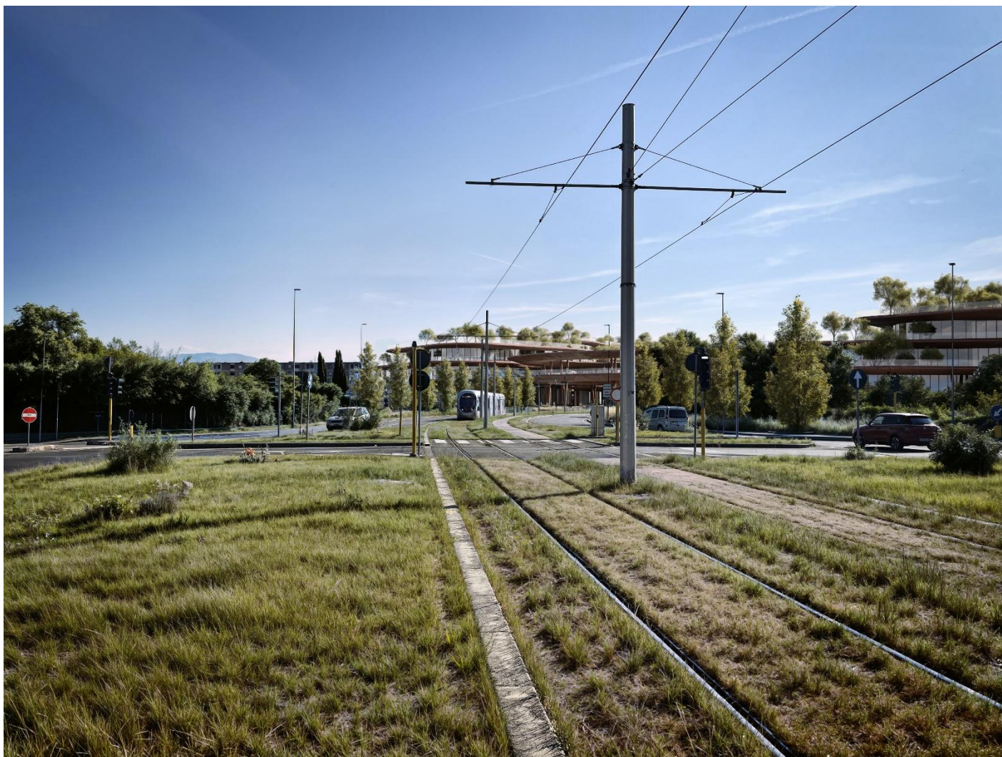
Figura 3 Foto 1 Post Operam
