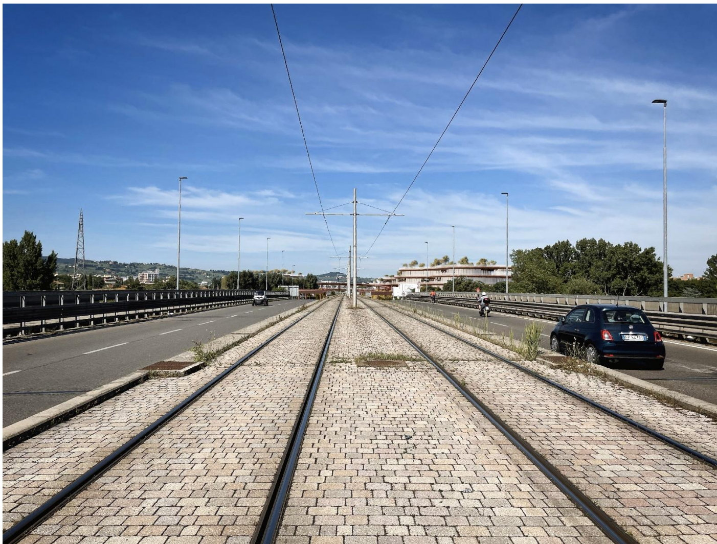
Figura 9 Foto 4 Post Operam
