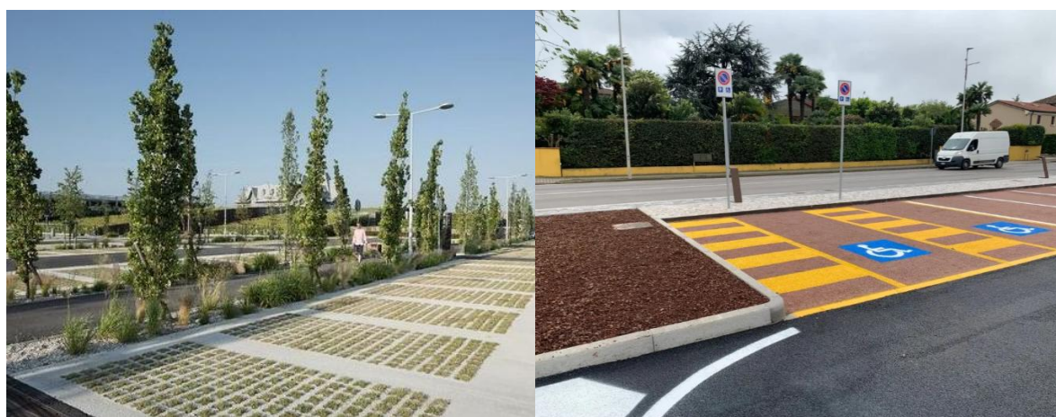
Figura 84. Pavimentazione drenanti parcheggi
