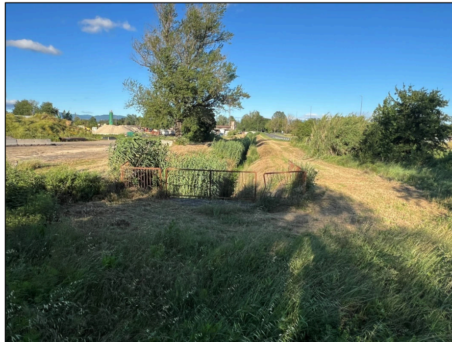
Fig. 23 Particolare del Fosso Rigone lungo l'attraversamento di Via del Chese.
