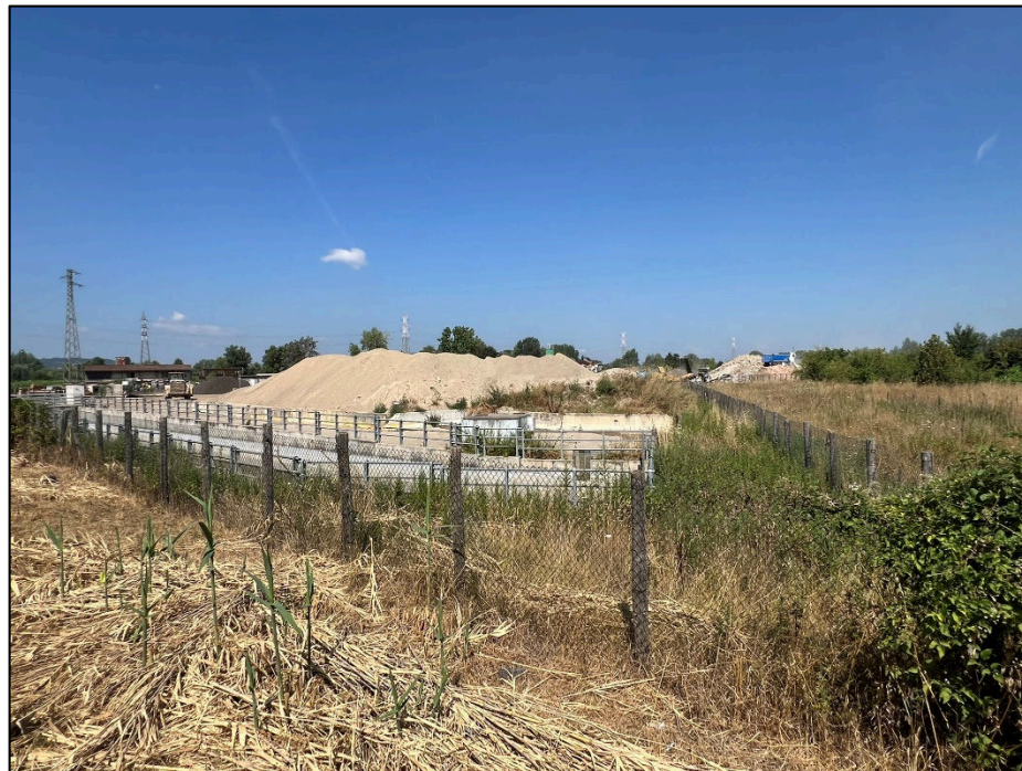
Fig. 22 Panoramica dell'area occupata dall'impianto di Italscavi s.r.l.
