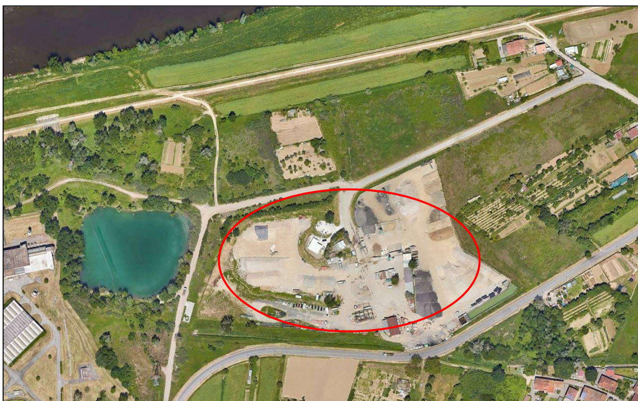
Figura 1: Impianto di trattamento e recupero rifiuti non pericolosi – Italscavi S.R.L. – Comune di Scandicci (FI).
