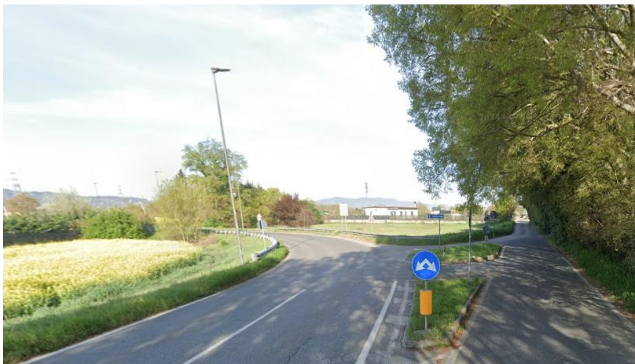
Figura 2-6: Via V. Masiani tratto est - Intersezione a raso con via del Chese
