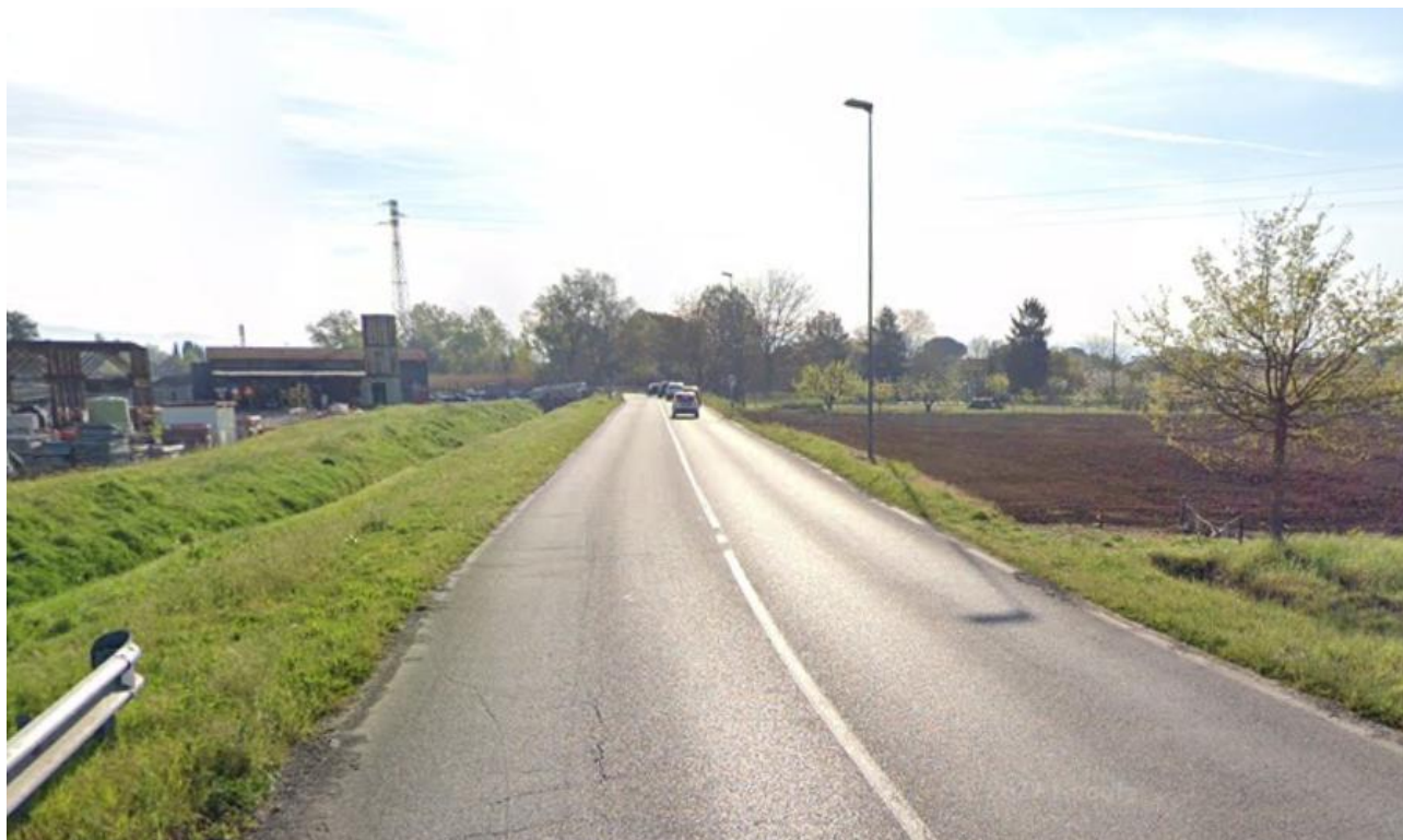
Figura 2-5: Via V. Masiani tratto a sud dell'area RQ 08e nel tratto in parallelismo con il corso d'acqua Fosso Rigone
