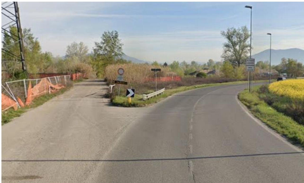
Figura 2-3: Via V. Masiani tratto sud - Intersezione a raso con via del Chese
