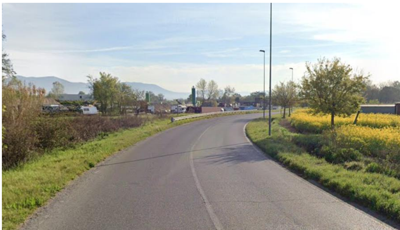
Figura 2-4: Via V. Masiani tratto a sud dell'area RQ 08e
