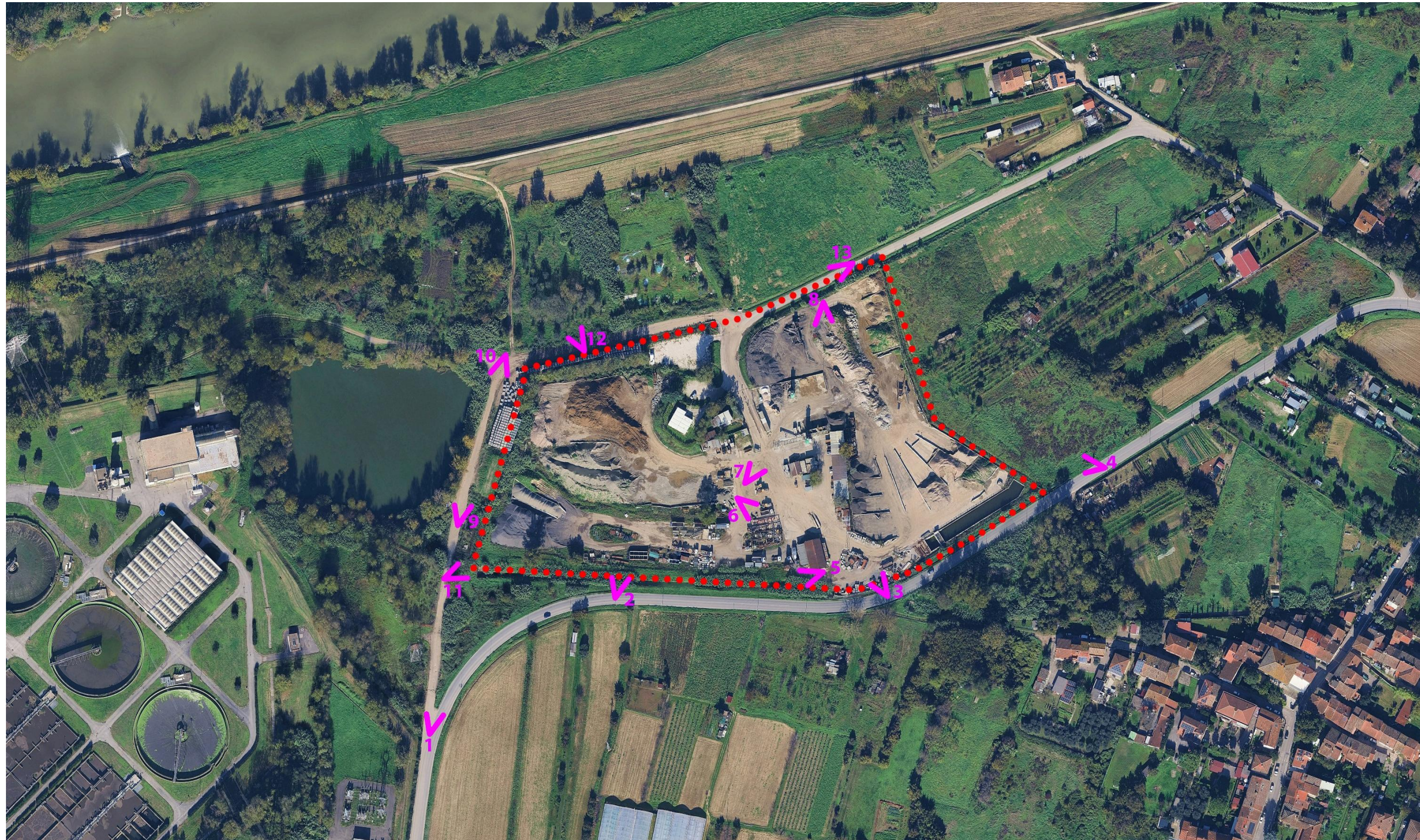
Figura 4-1: Vista Aerea con punti fotografici
