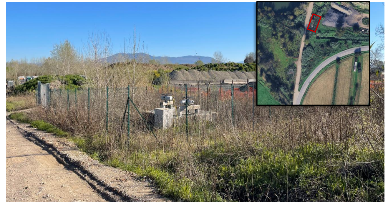
Figura 5-13: Manufatto di controllo del sistema fognario in soprasuolo all'interno dell'area recintata lungo via del Chese
