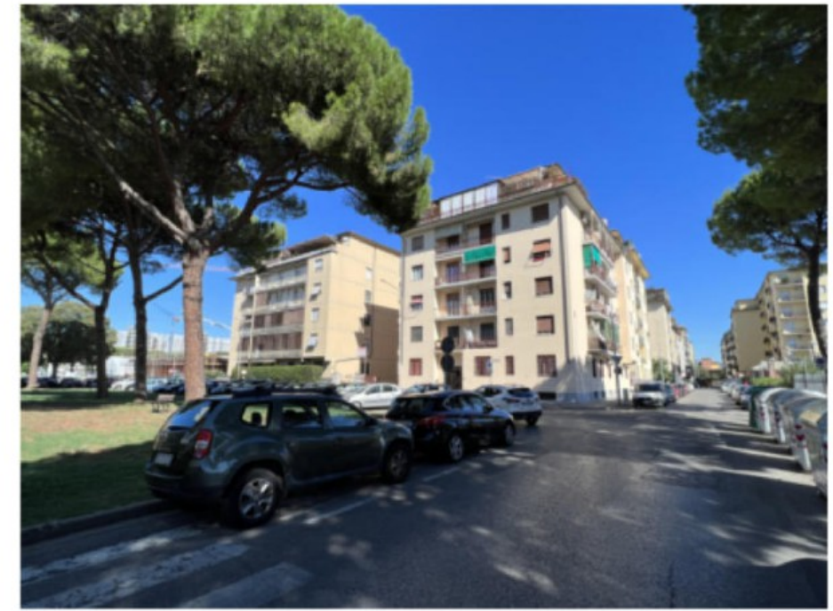
foto 9: particolare degli edifici prospettanti sui giardini Boccaccio
