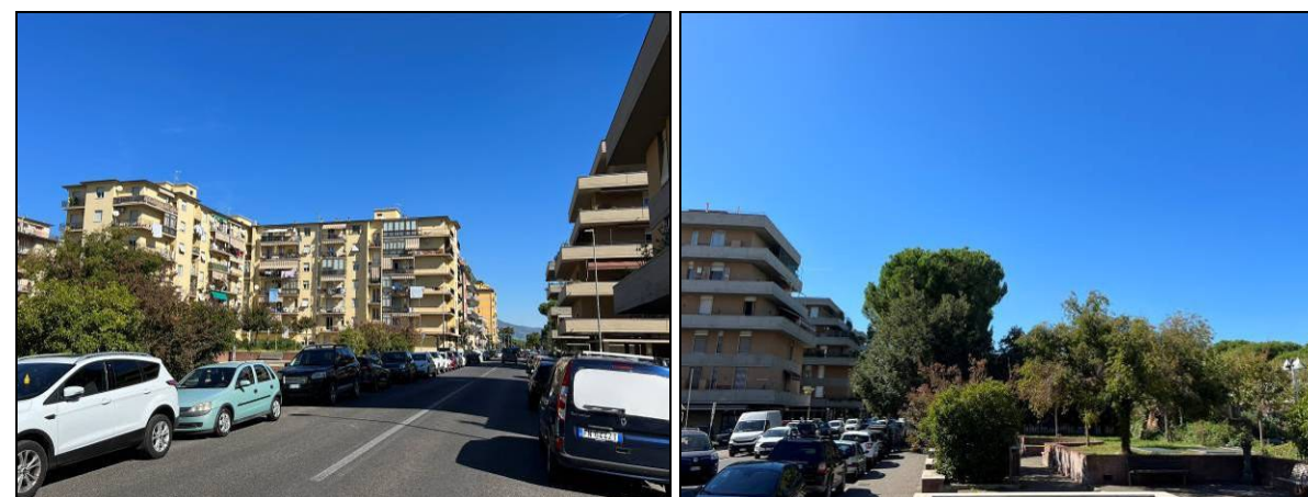
foto 3 - 4: viste fabbricati su Via Ugo Foscolo
