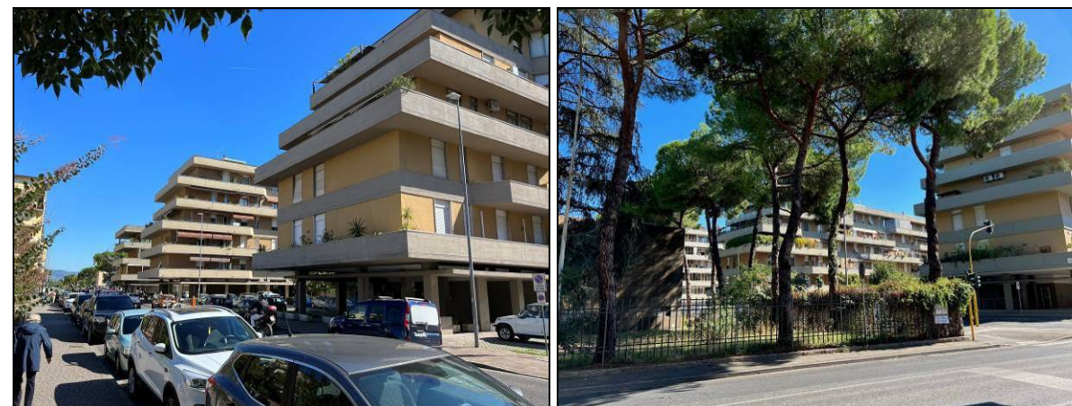
foto 1 - 2: viste fabbricati su Via Ugo Foscolo
