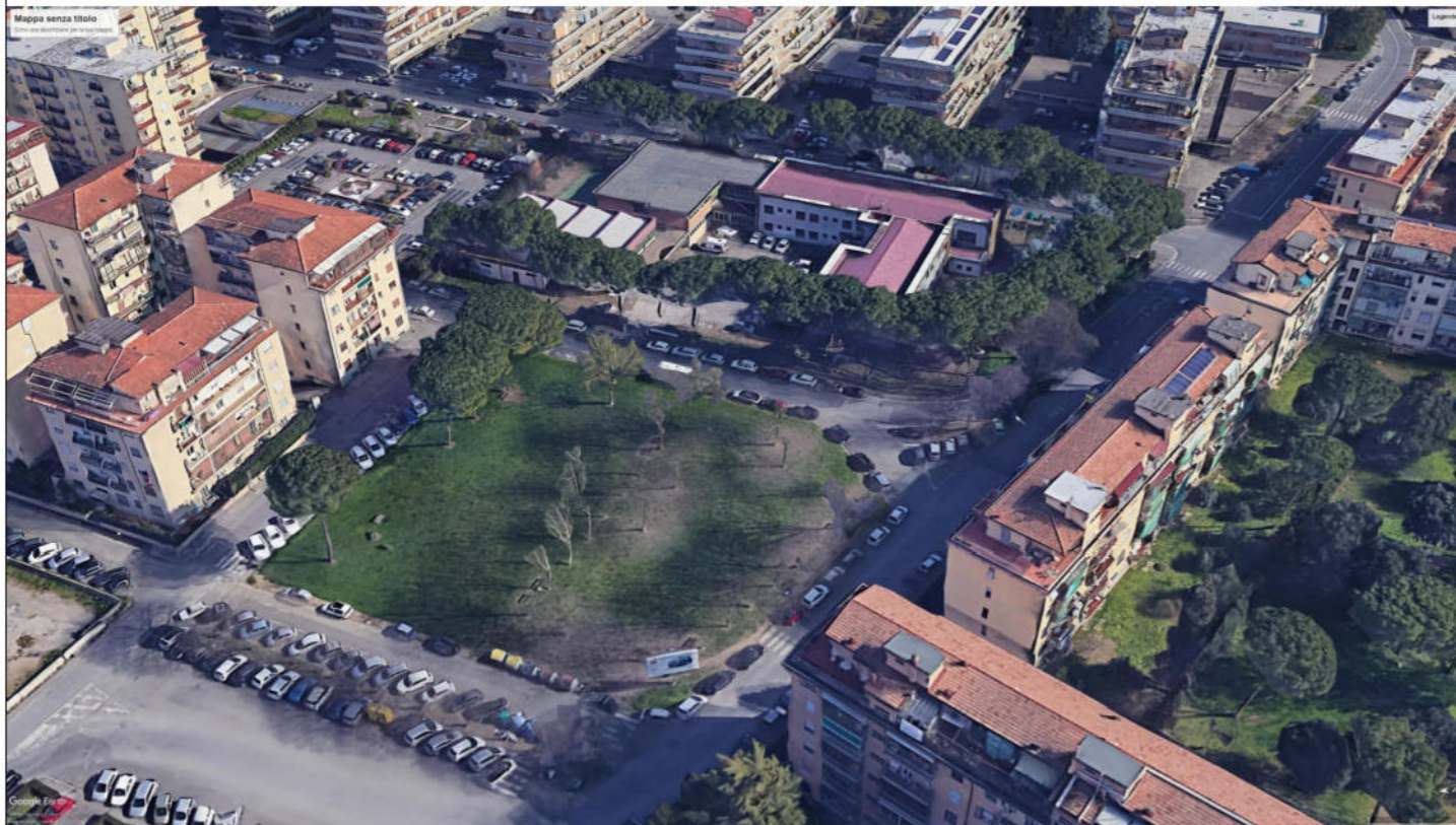
3- STATO ATTUALE - ESTRATTO DA GOOGLE EARTH - Vista aerea da ovest
