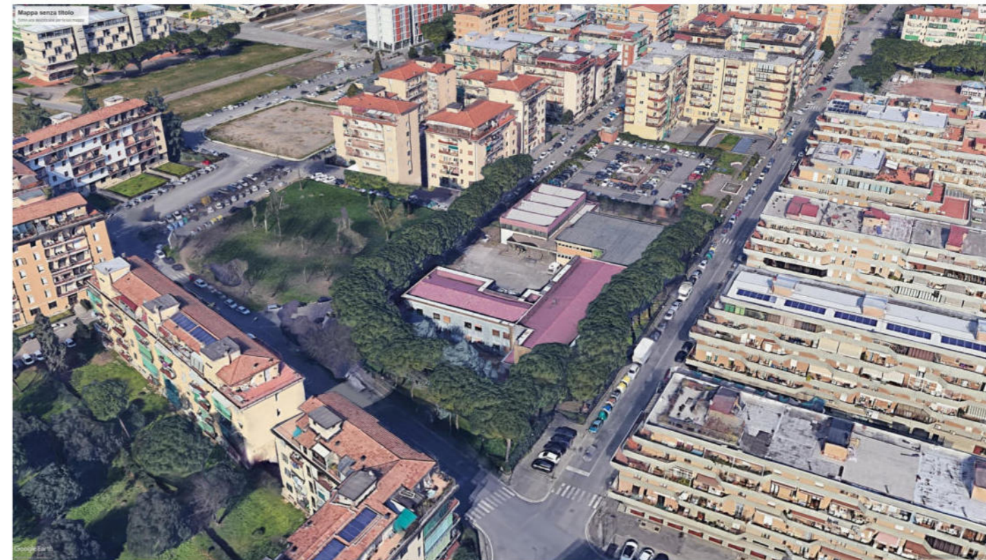
4- STATO ATTUALE - ESTRATTO DA GOOGLE EARTH - Vista aerea da sud
